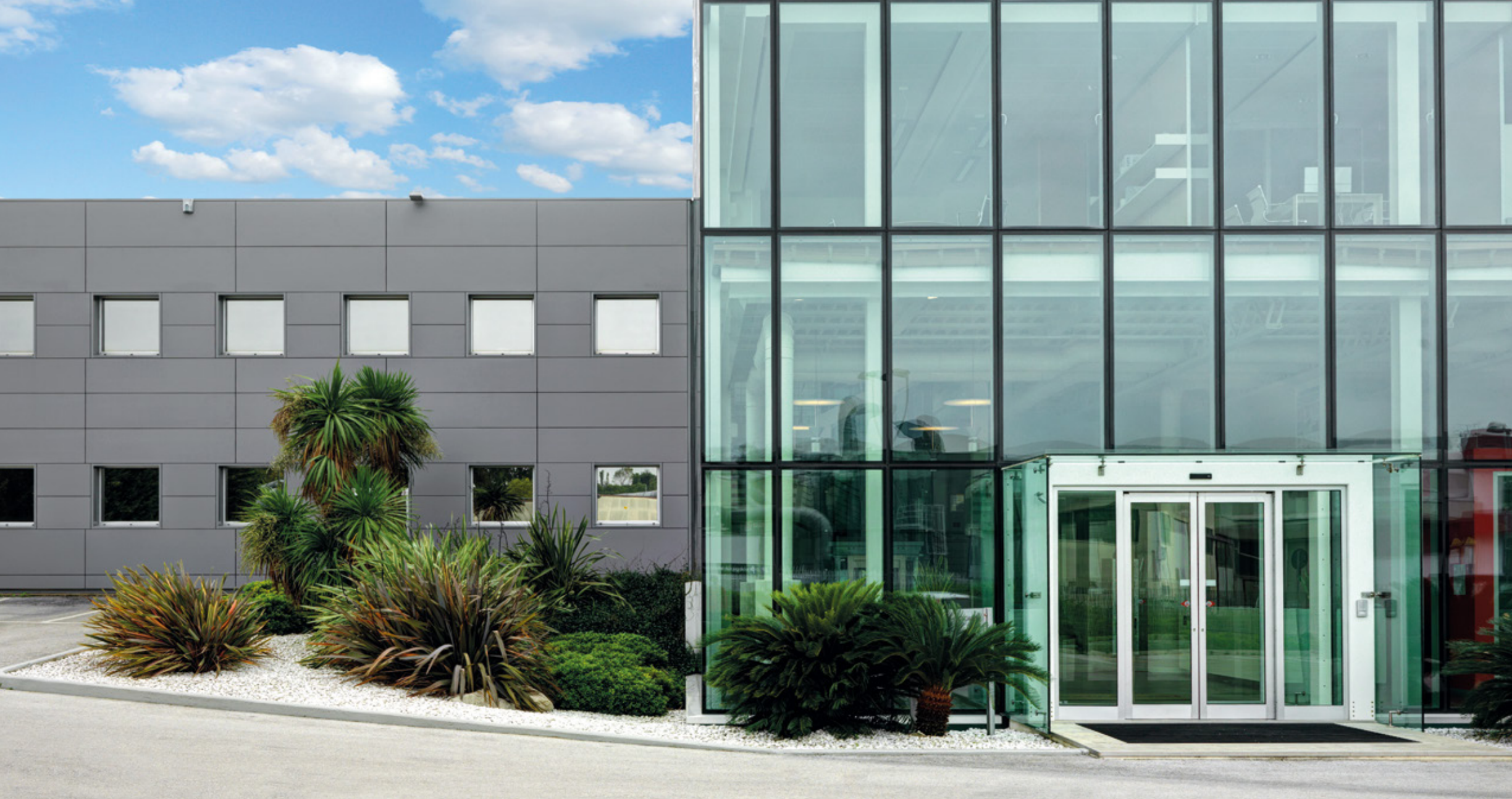
Ingresso Sede centrale | Uffici direzionali - Uffici tecnici Entrance to the Headquarter | Head offices - Technical offices
